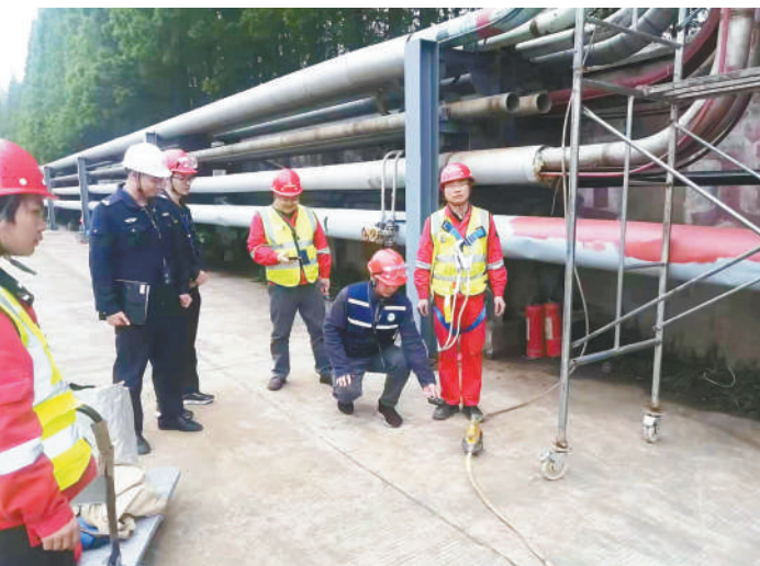
图为执法人员开展现场检查。
