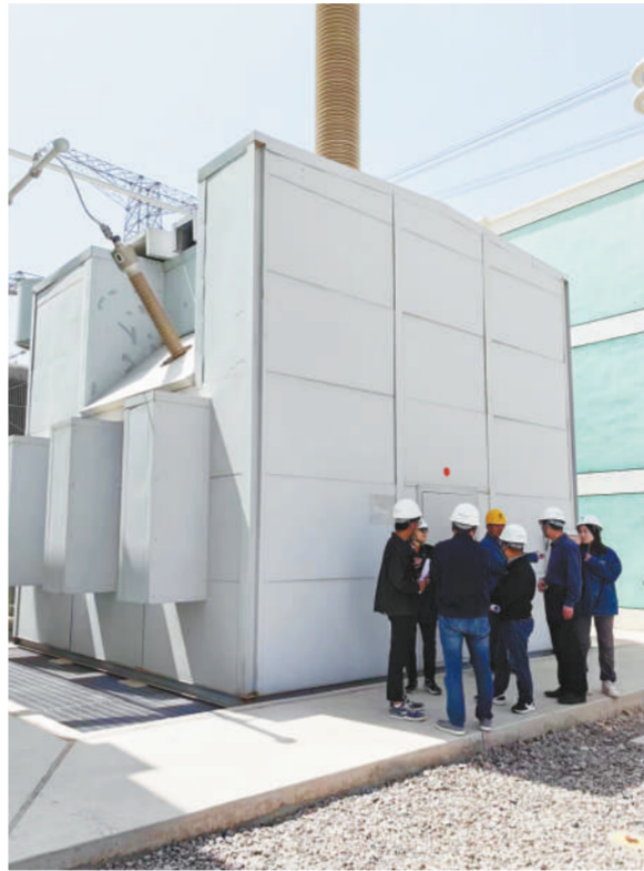
图为工作人员现场踏勘河西750千伏变电站第三主变扩建工程。
