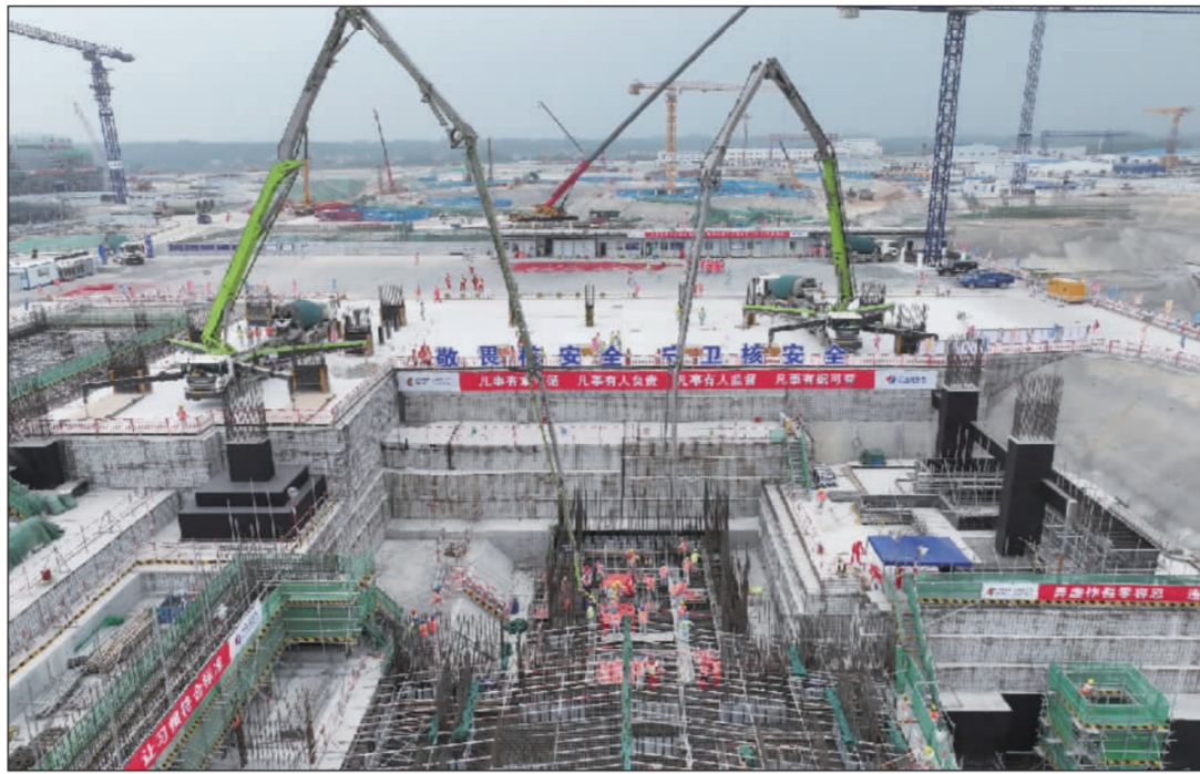
▲图为廉江核电项目一期工程2号机组常规岛汽机基础底板混凝土浇筑现场。
