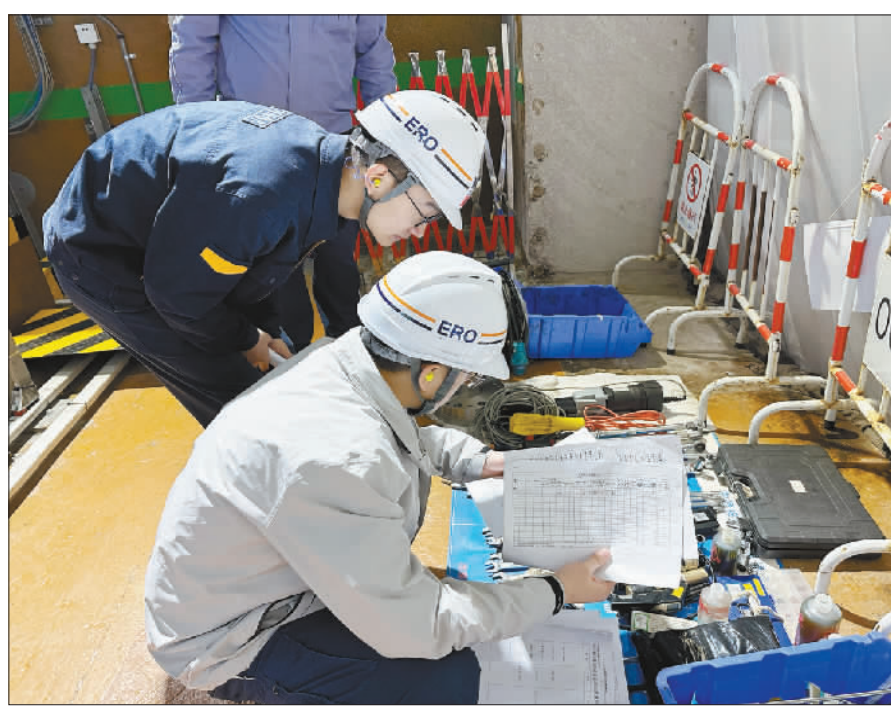
生态环境部华东核与辐射安全监督站近期现场释放宁德核电厂2号机组第七次换料大修后临界控制点。华东核与辐射安全监督站始终坚持严的主基调,严格执法,对在大修中出现的苗头性问题及时开展现场监督检查,对临界前需完成的要素项目逐项核实。
