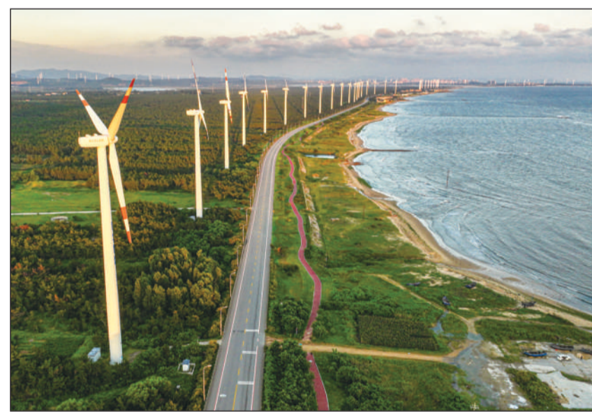
近年来,山东省荣成市依托沿海丰富的风能、光能资源,规划布局清洁能源建设,建成的大批新型风力发电、光伏发电等绿色能源,有力推动了当地经济发展,助力乡村振兴。图为荣成市北部沿海风力发电场。
