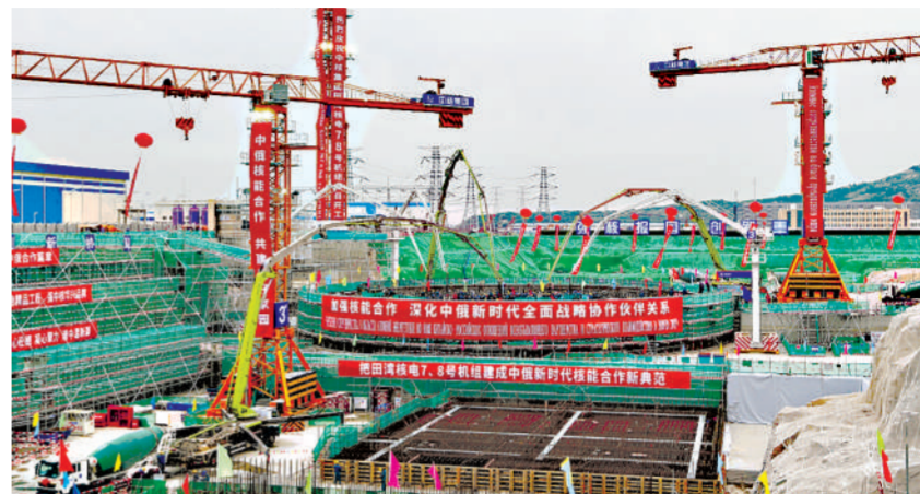
图为田湾核电7号机组开工现场。 路振扬摄
