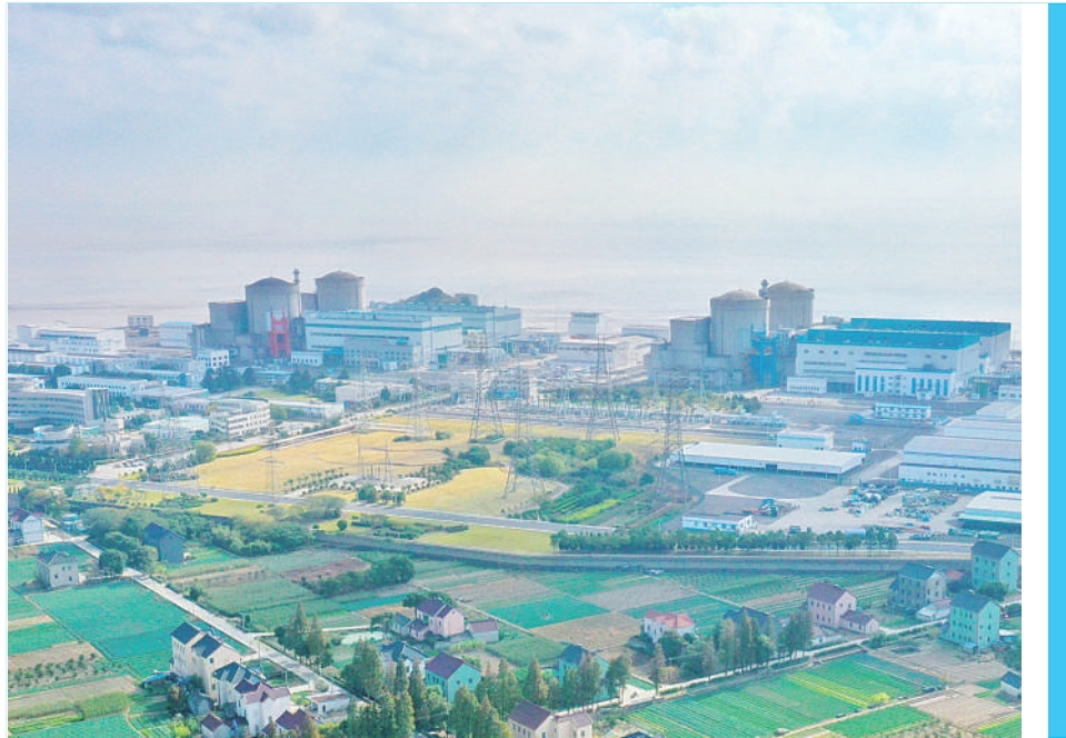
图为泰山核电站。
