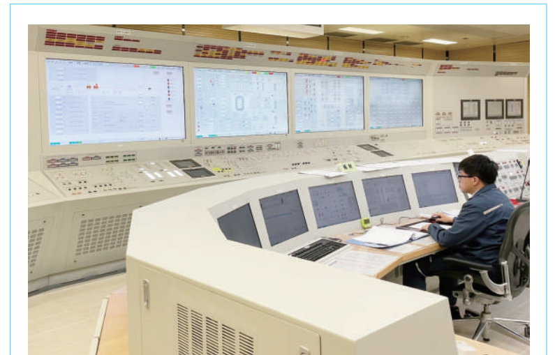
据中国广核集团通报,5月2日13时42分,随着并网指令的发出,辽宁红沿河核电站6号机组首次并网成功。这标志着红沿河核电站6号机组具备发电能力,向着商业运行目标迈出了关键一步。孙浩供图
