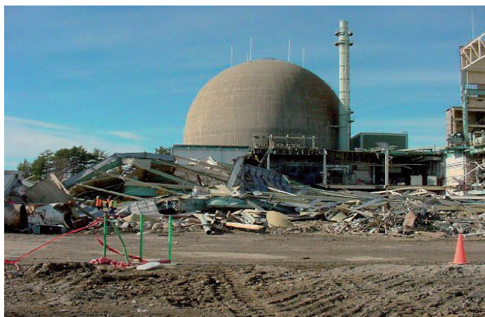
图5-2 美国Maine Yankee核电厂退役拆除现场
