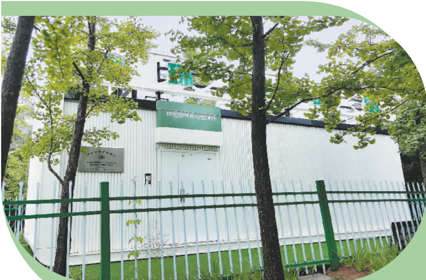
图为西安市中湖公园内的大气辐射自动监测站。
