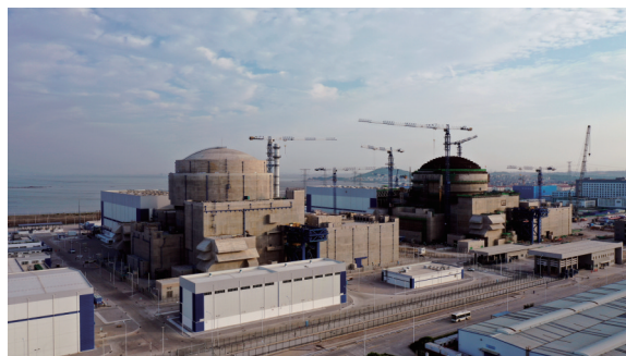
图3 “华龙一号”福清现场
