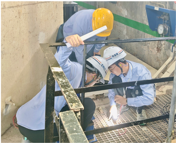
图12 宁德核电厂联合泵房监督检查
