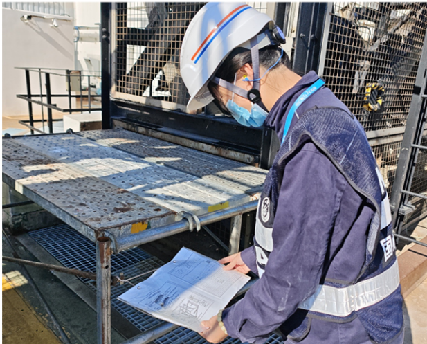
图9 岭澳核电厂海水泵房监督检查
