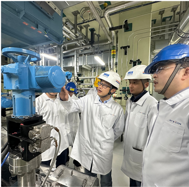
图25 太平岭核电厂1 号机组核岛监督检查
