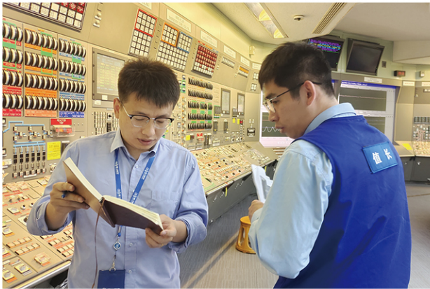
图6 秦山第三核电厂主控室监督检查
