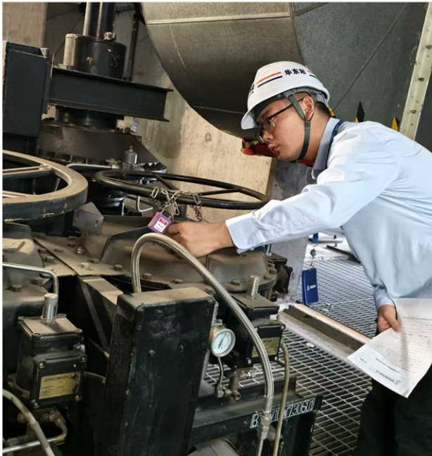
图 13 福清核电厂主蒸汽隔离阀间监督检查
