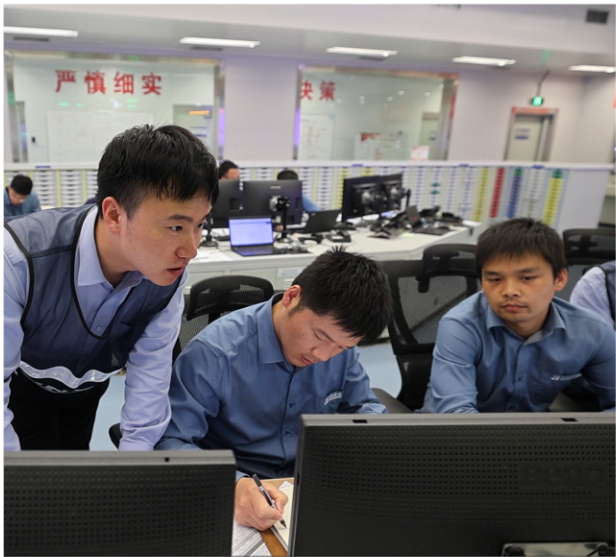
图21 石岛湾核电厂主控室监督检查
