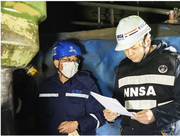
图10 田湾核电站8 号机组主管道焊接监督检查
