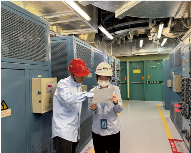
图7 方家山核电厂电气厂房监督检查
