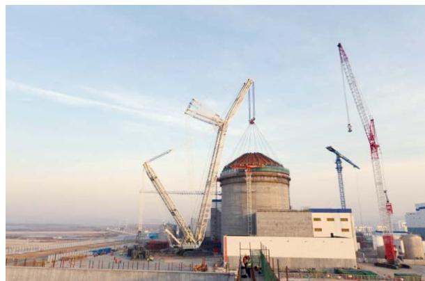
图 17 海阳核电厂 1 号机组屏蔽厂房钢穹顶吊装就位
