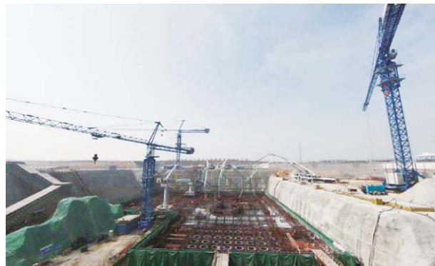
图25 核岛底板2m层混凝土浇筑
