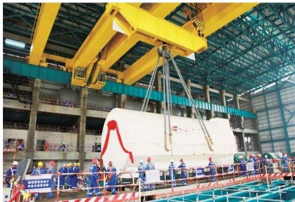
图 22 防城港核电厂1号机组发电机定子就位
