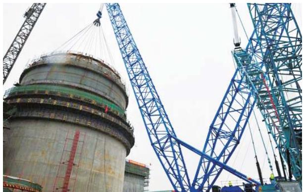
图15 三门核电厂1号机组顶封头吊装就位
