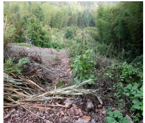
白石坡工区废石堆现状
