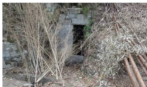
李家团工区坑口
