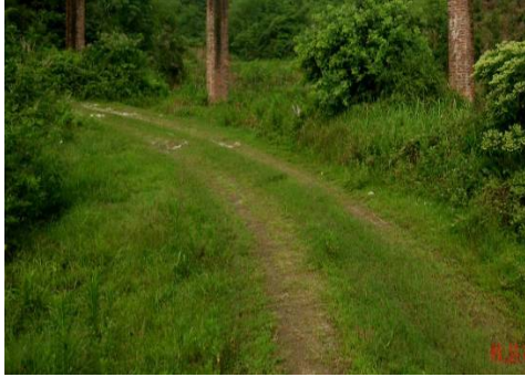
水冶厂工区运矿公路现状
