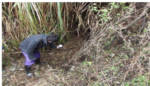
老屋场工区坑口
