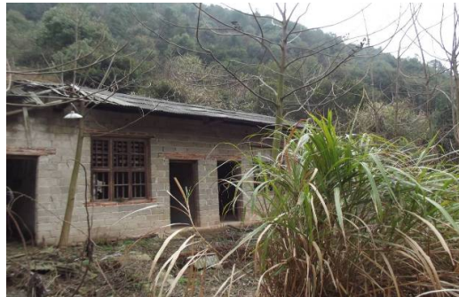
大富岭工区遗留建（构）筑物现状
