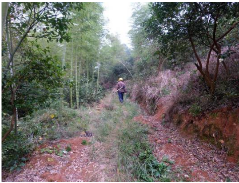
严仙岭工区运矿公路现状
