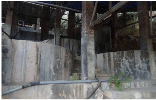
水冶厂部分遗留建（构）筑物现状
