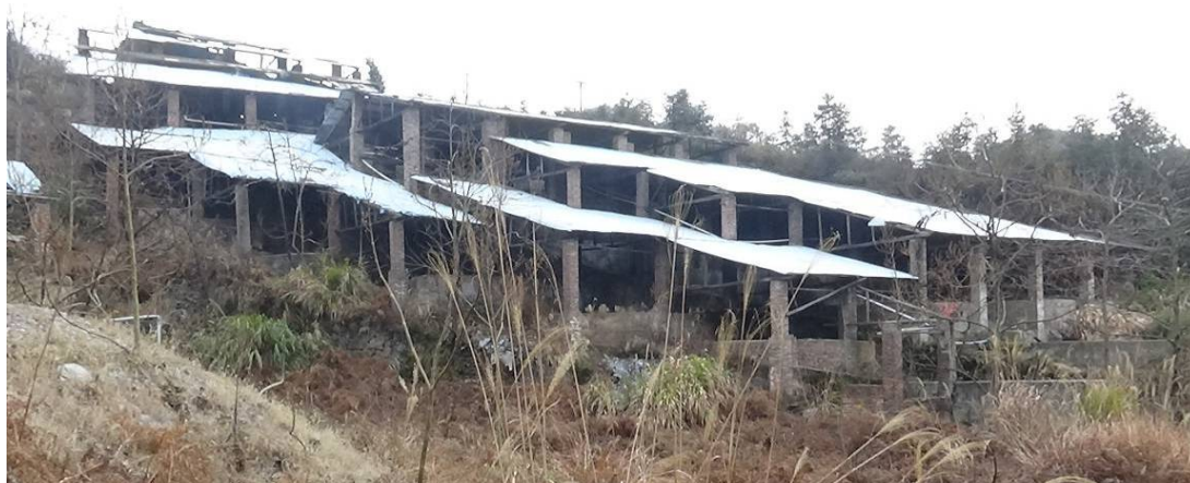
图 5.2-4 水冶厂工区工业场地现状图片
