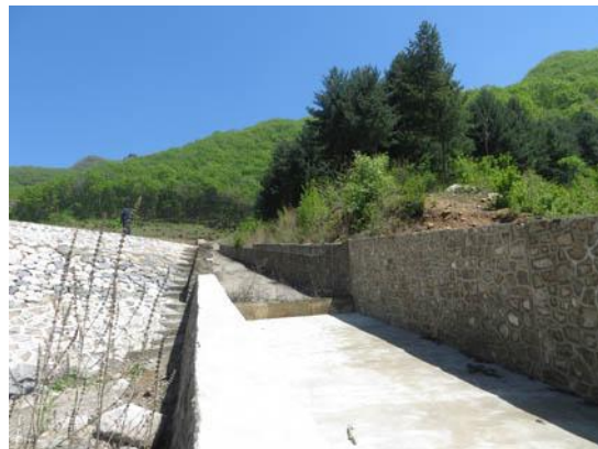
3-8 排洪设施治理后照片
