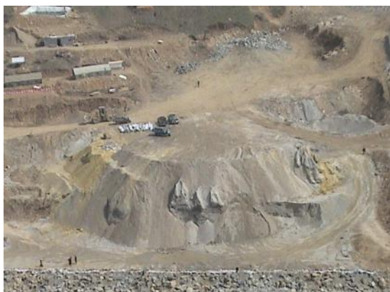
图 3-5 尾矿堆积坝及滩面治理前照片
