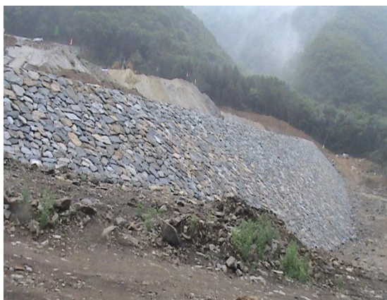
图 3-2 砌石坝退役治理前照片
