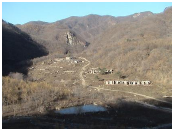
图 3-9 水冶厂治理前照片
