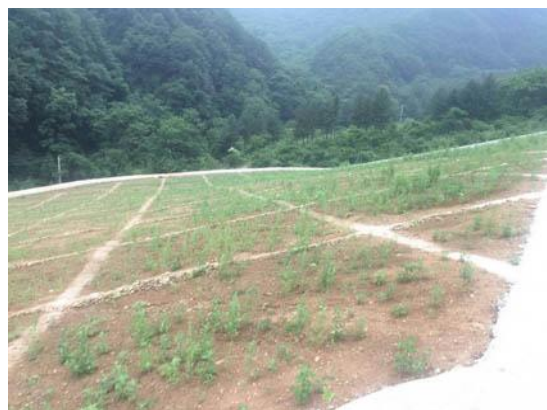
3-6 尾矿堆积坝及滩面治理后照片
