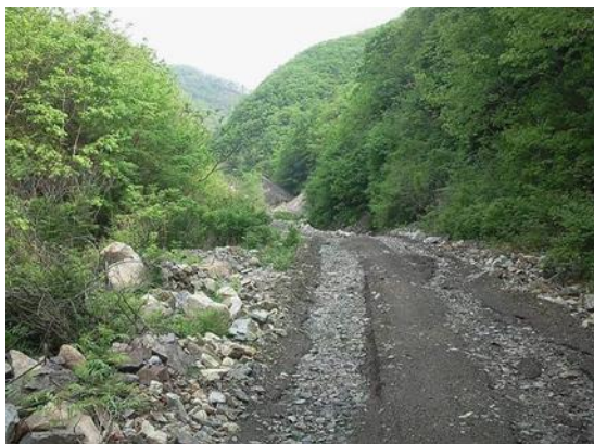
图 3-11 运矿公路治理前照片
