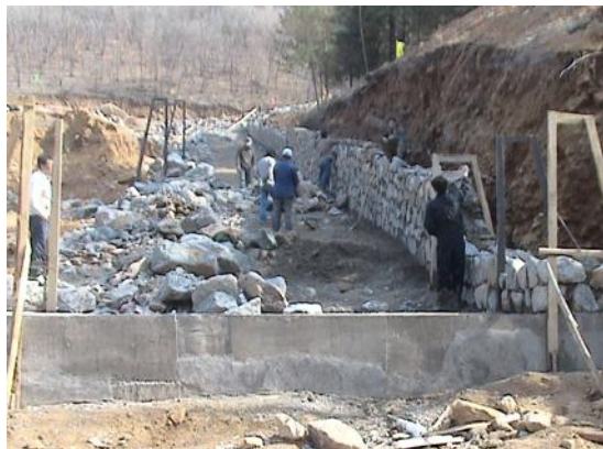
3-7 排洪设施治理中照片
