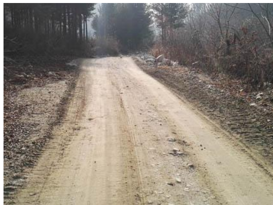
图 3-12 运矿公路治理后照片
