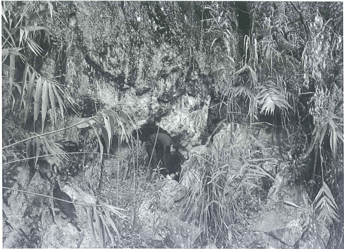
图 2-1 小水矿点塌陷区 9
