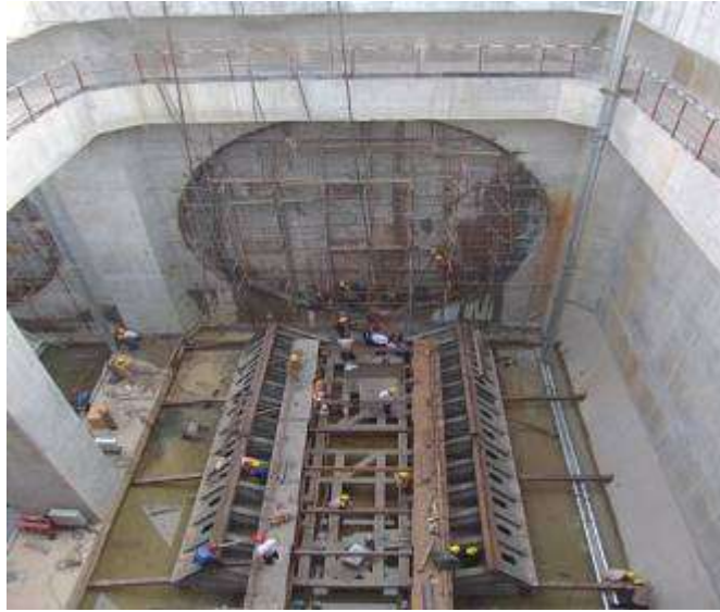
图 3.1-4 同类工程盾构隧道工作井现场照片
