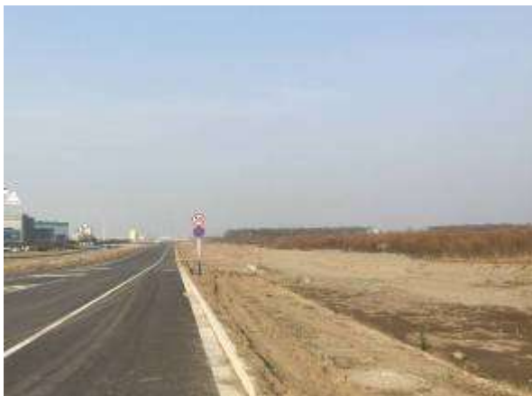
图 4.2-1 北端引接站现状
