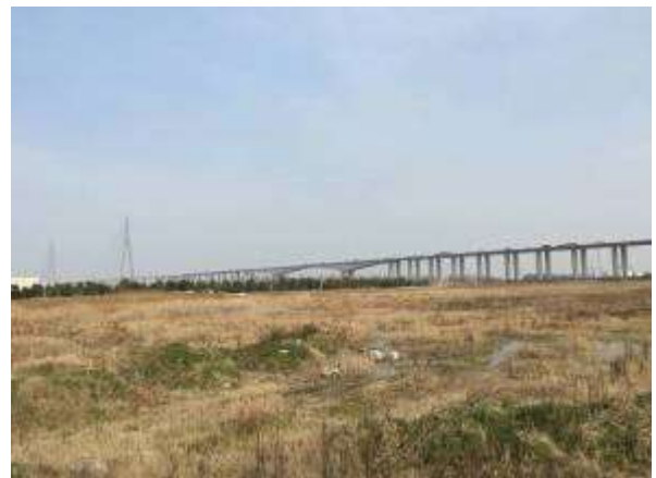
图 4.2-2 南端引接站现状
