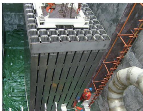
图2-3-16 燃料格架安装现场
