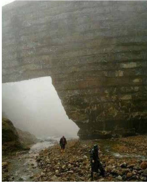
图1-4-5 南天水电站蓄水坝溃坝现场
