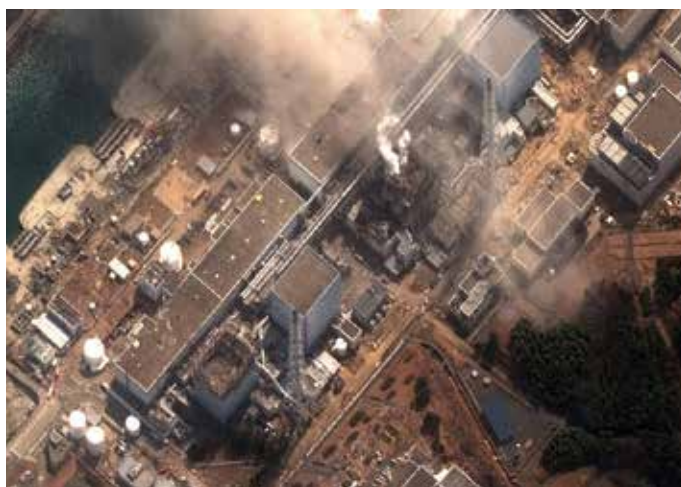
图1-4-10 福岛事故现场俯瞰
