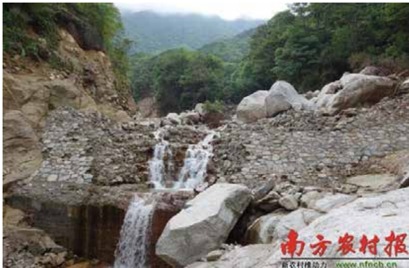
图1-4-6 大平坳电站溃坝
