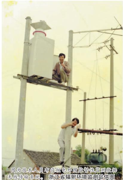
图为技术人员架设核电外围监督性监测数据无线传输系统。浙江省辐射环境监测站供图
