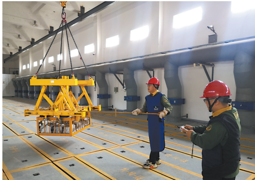
图为广西辐射站工作人员将已收回的废旧放射源吊装到贮存位。 高德年摄
