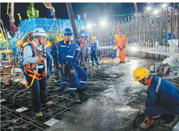
生态环境部华东核与辐射安全监督站近日对漳州核电厂4号机组核岛基础第一罐混凝土浇筑(FCD)活动开展监督检查。
