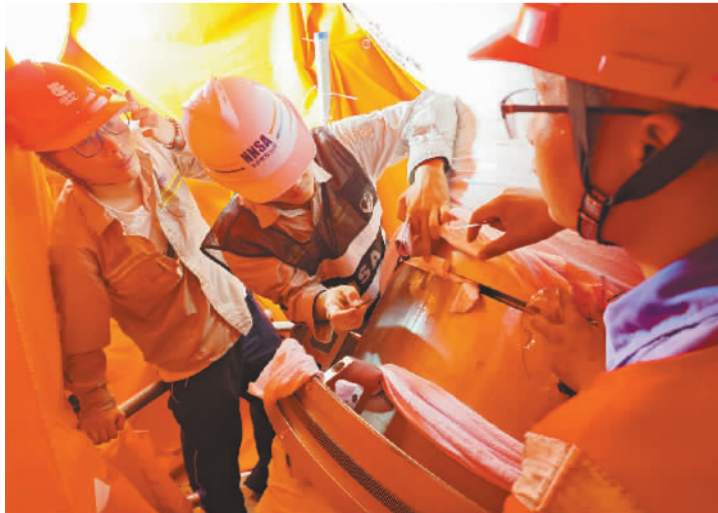
图为华东监督站监督员在海阳核电3号机组开展主管道焊接检查。 华东监督站供图
