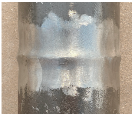
图 5 角磨机修磨后的焊缝
