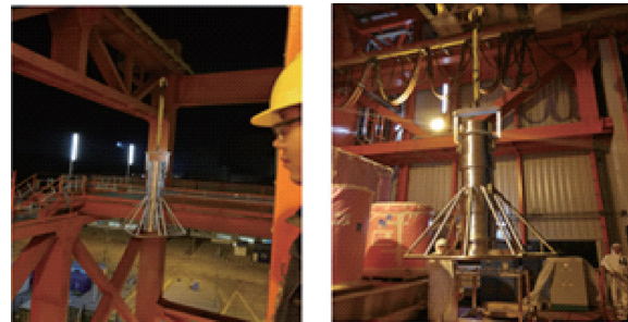
图5 运输容器吊运至20米鸡笼暂存
