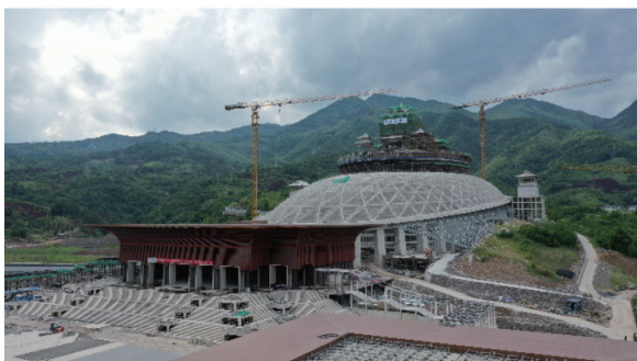
浙江佛学院二期仿古建筑施工
