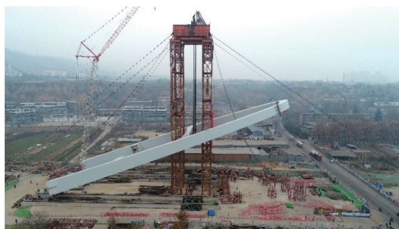
韩城太史大街西延桥超大吨位拱形钢索塔卧拼竖提转体
