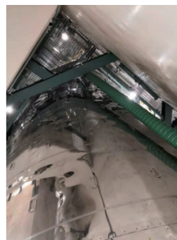
图3 蒸汽发生器隔间现场图(二)
