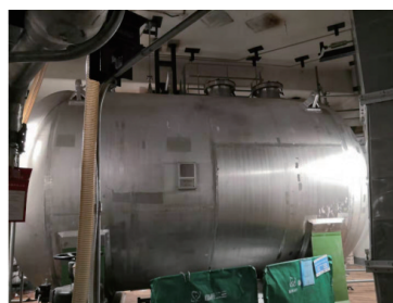
图8 卸压箱隔间现场图(一)
