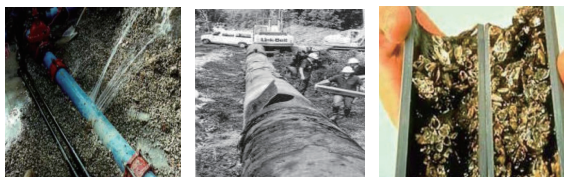
(a) 泄漏 (b) 破裂 (c) 阻塞
