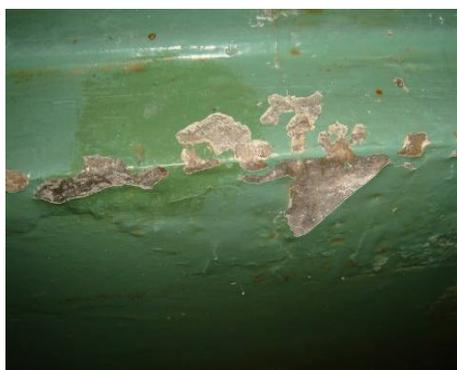
图1 某核电厂安全壳内局部混凝土表面涂层脱落
