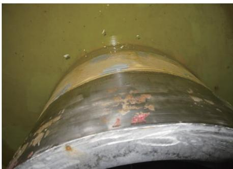
图2 某核电厂安全壳内管道表面涂层脱落
