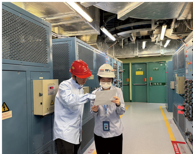
图7 方家山核电厂电气厂房监督检查
