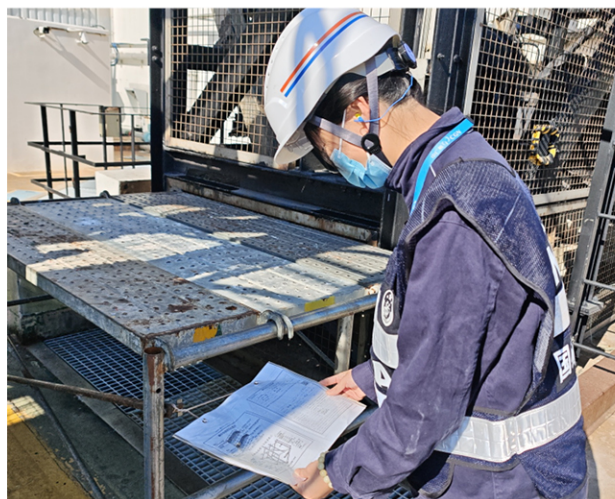
图9 岭澳核电站海水泵房监督检查
