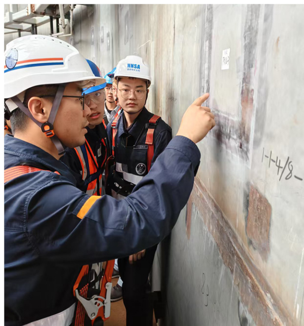
图29 廉江核电厂CV附板切割重焊情况监督检查
