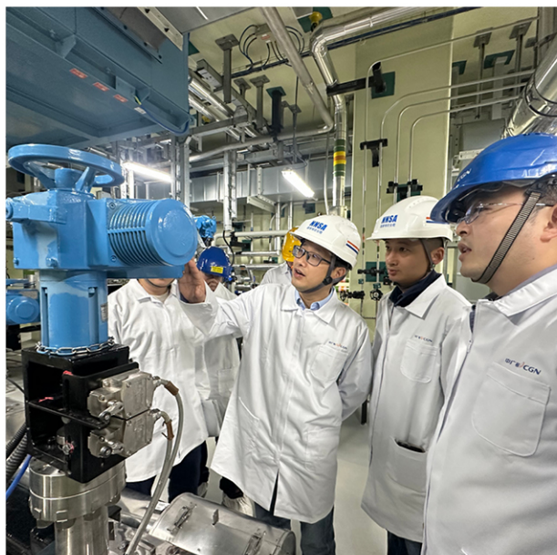
图 25 太平岭核电厂 1 号机组核岛监督检查
