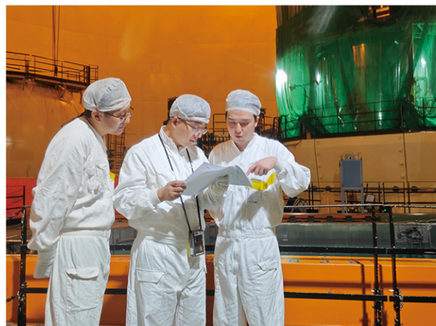
图8 大亚湾核电厂D224 换料大修监督检查
