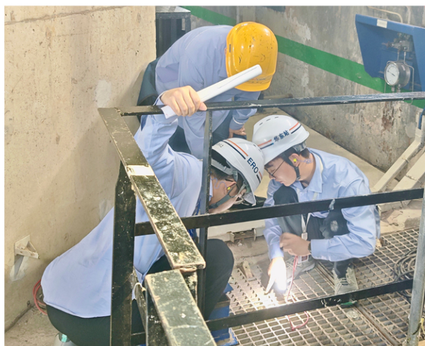
图 12 宁德核电厂联合泵房监督检查
