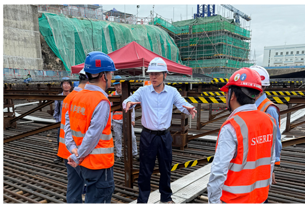
图28 陆丰核电厂2号机组核岛底板钢筋绑扎监督检查
