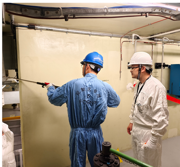
图20 防城港核电厂核辅助厂房监督检查
