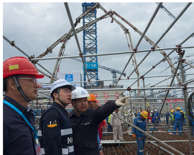
图22 石岛湾核电站扩建一期2号机组FCD监督检查
