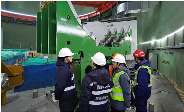
图25 徐大堡核电厂3 号机组主管道焊接控制点检查
