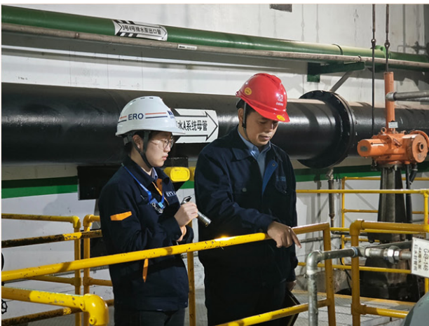
图3 秦山核电厂海水泵房巡视
