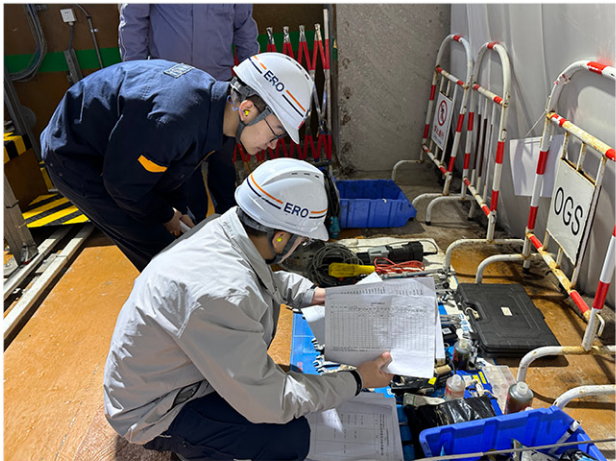
图11 宁德核电厂2 号机组大修期间设备再鉴定试验监督现场
