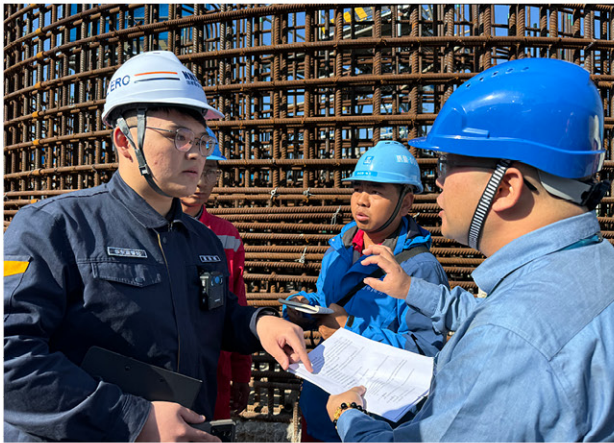
图20 石岛湾核电厂扩建工程监督现场
