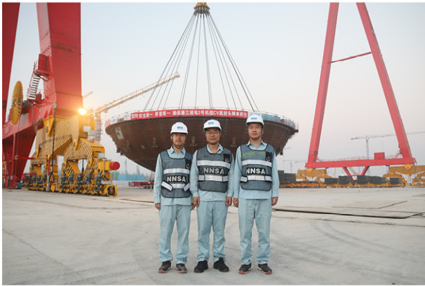
图27 廉江2号机组CV底封头吊装
