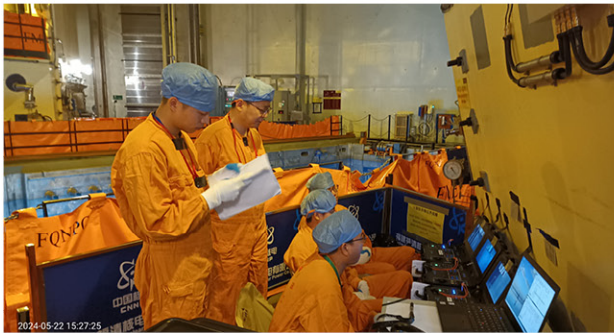
图12 福清核电厂4号机组410小修卸料操作监督现场
