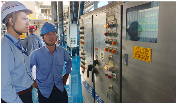
图5 秦山第三核电厂海水泵房巡视
