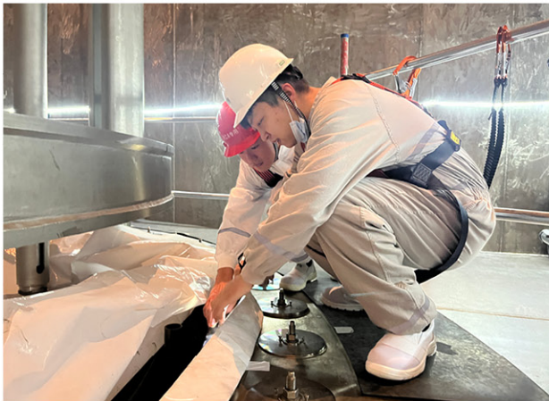
图 21 国核示范压力容器开盖密封面检查
