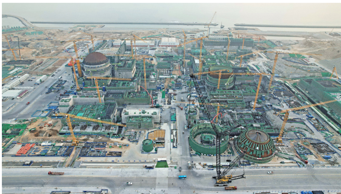
图 20 徐大堡核电厂 3、4 号机组建造现场
