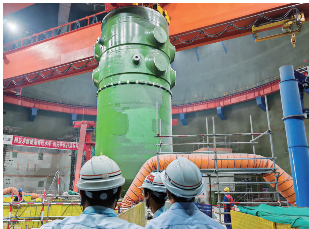
图 4 田湾核电站 7 号机组压力容器吊装过程监督
